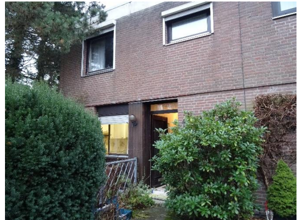
Vorderansicht der Doppelhaushälfte
