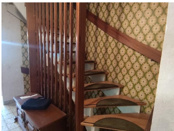
EG: Treppe EG - OG
