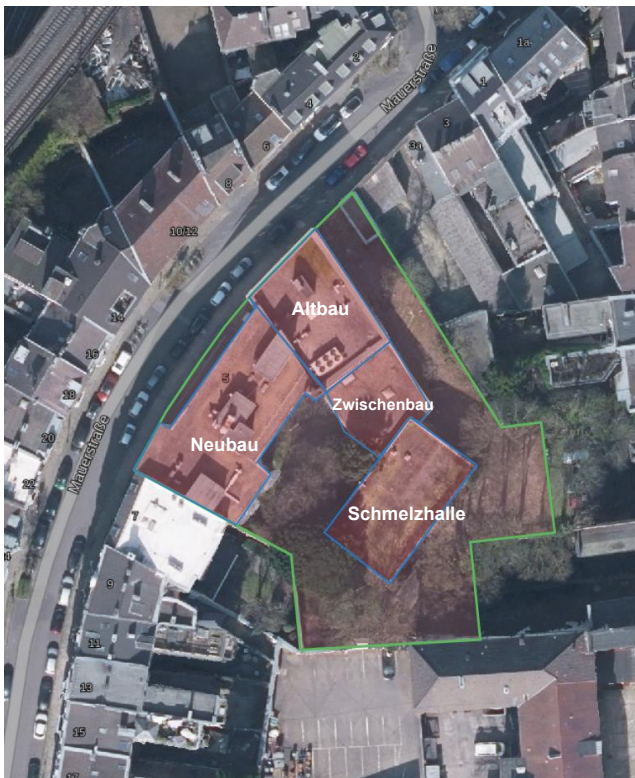
Luftbild mit Grundstück und Gebäuden
